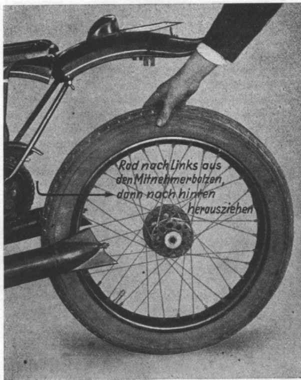
Abb. 14. Hinterrad-Demontage.
