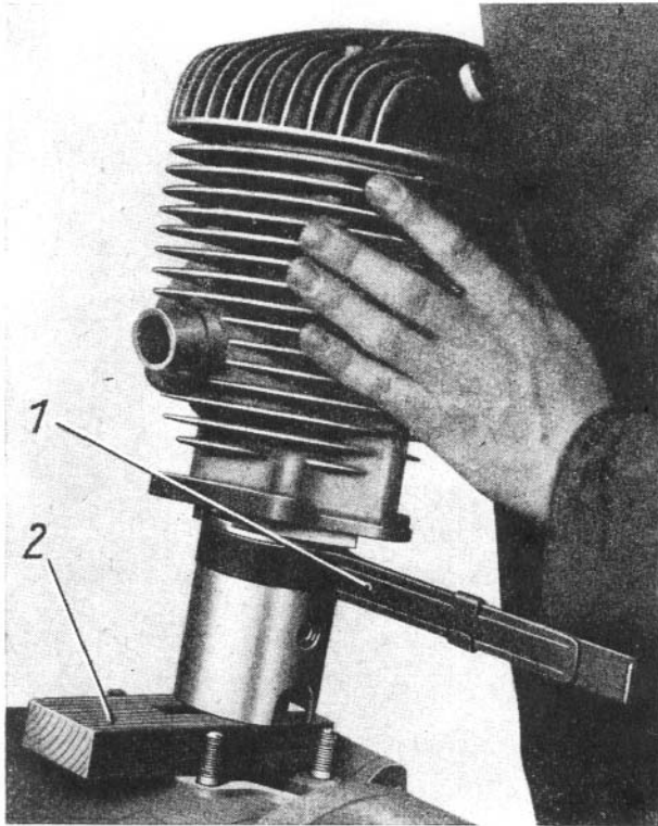
Bild 43. Aufsetzen des Zylinders
